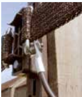
Du câble haute tension avec des connecteurs pour acheminer le courant jusqu'au ruban.
